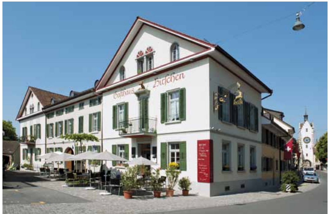
Der neu renovierte «Hirschen» in Diessenhofen, Thurgau
